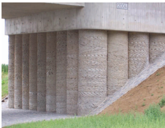
OBRÁZEK E.1: Příklady pilot s vrypami, neovlivňujícími minimální krycí vrstvu pro trvanlivost
