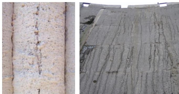
OBRÁZEK E.3: Příklady kanálků probíhajících vzhůru po povrchu piloty nebo podzemní stěny
