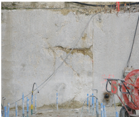
OBRÁZEK E.2: Příklady inkluzí v podzemní stěně a v pilotě (foto piloty je vzato z obrázku 9.14b, FHWA GEC10)
